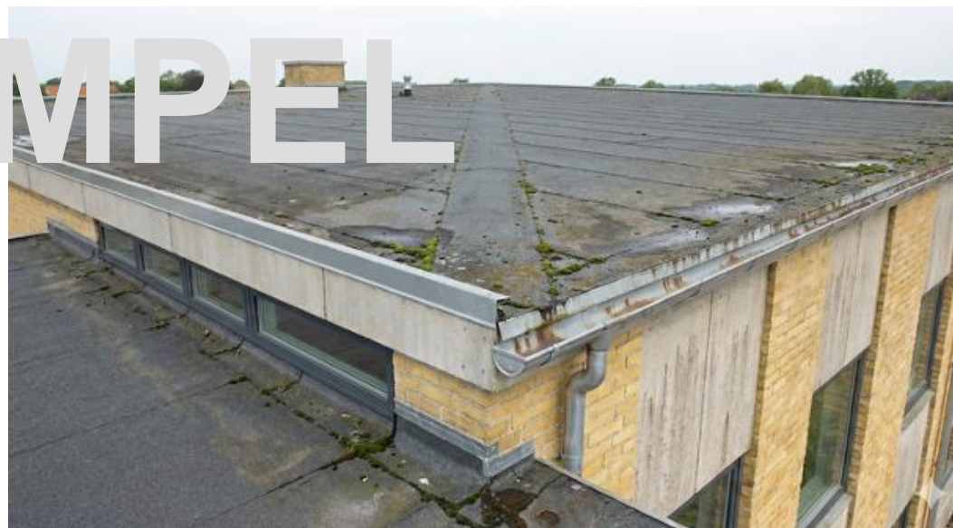
Illustration: Taget efterses og lappes periodevis når det vurderes snart at kunne regne ind.
