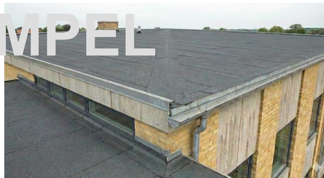
Illustration: Tagpaptaget er nyligt vedligeholdt og tagrenderne repareres løbende.
